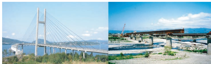
図 軽量コンクリートを使用した橋梁
