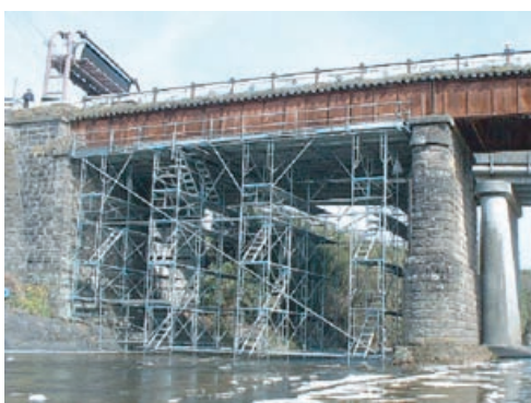
図 架調査用足組み
