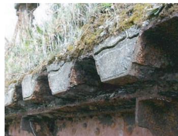
図 床版張り出し部状況
