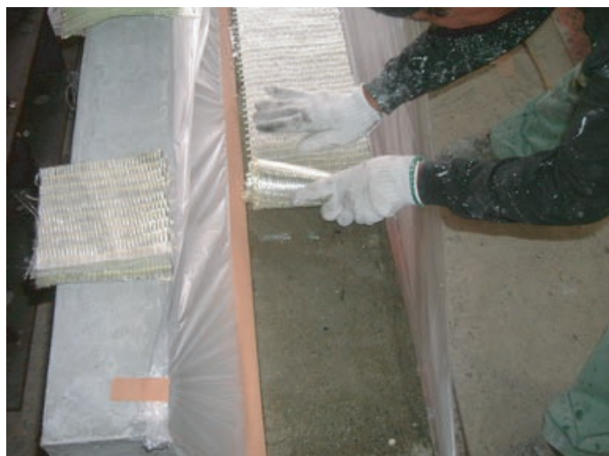
図 GFシート貼り付け
