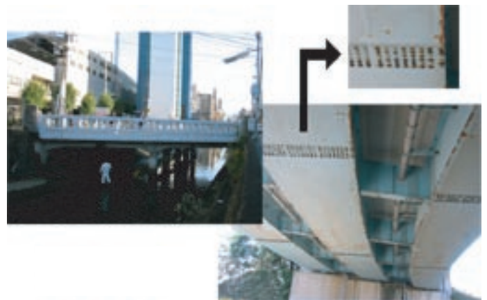
図 橋梁点検状況
