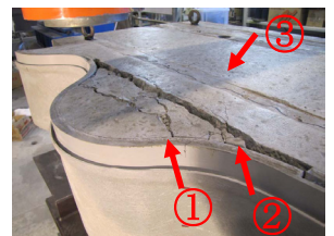
写真-1 ひび割れ状況
