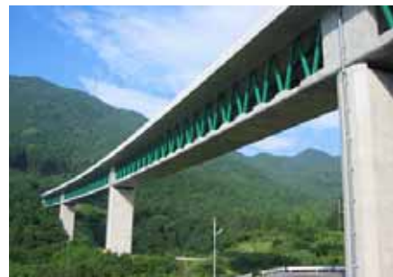
写真-1 木ノ川高架橋
