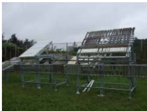
図-2 暴露試験状況
