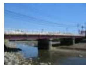
写真-1 A 橋全景
