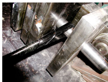
図-3 U型アンカーの緊張治具設置状況
