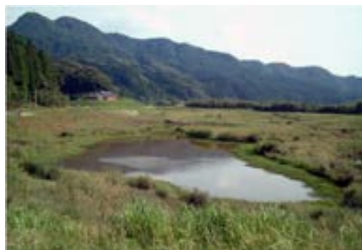
アザメの瀬。松浦川中流部の、かつて水田であった場所に設けられた湿地です。洪水対策のための機能を持っていますが、同時に、過去に失われた自然の再生という役割も担っています。河川工学、農学、生態工学などの知恵と経験を結集してつくり、今日も地元の市民の皆さんとともに環境観察が継続されています。
